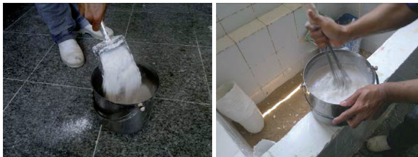
Figura 13 – Preparação do gesso
