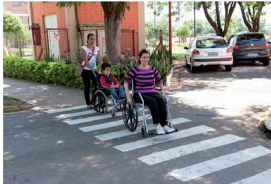
Figura 6 – Guia rebaixada de calçada
