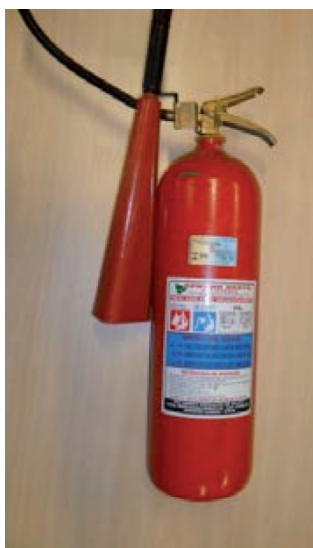
Figura 3 – Extintor Gás Carbônico
